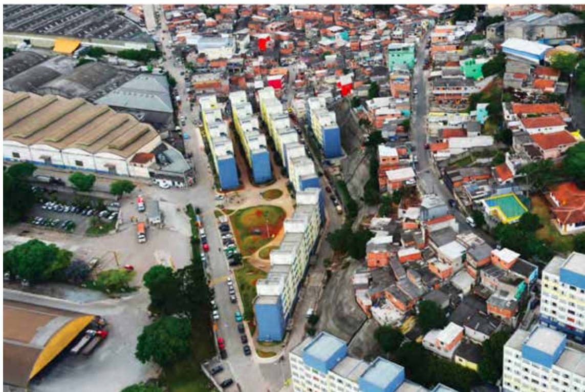
Figura 8 — Vista geral de estruturas geotécnicas e praça do Conjunto Nova Jaguaré.
