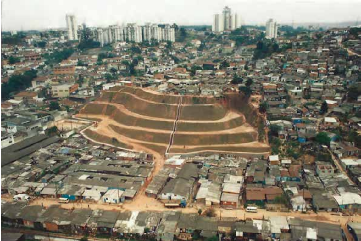
Figura 3 — Foto da área de risco após as obras de contenção (retaludamento e drenagem).
