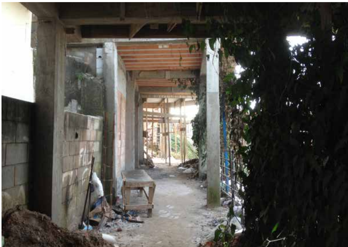
Fotografia 14 — Reocupações: moradia no sistema viário.
