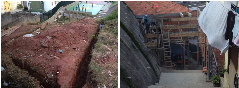
Figuras 8 e 9 – Escavações na praça (esq.) e ocupações sobre escadas (dir.). Imagens de junho de 2014.
