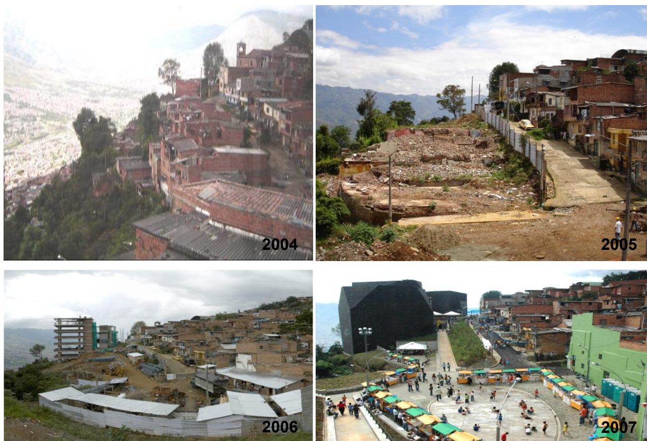
Figura 11. Processo de construção do Parque Biblioteca Espanha Santo Domingo Savio Fonte: EDU (2005) Arquivo fotográfico do Projeto Urbano Integral – PUI.
