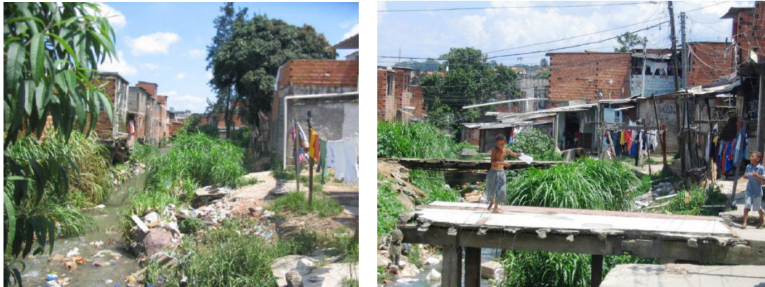
Figura 2 - Córrego ocupado antes da intervenção. Fonte: Grosbaum, 2012
