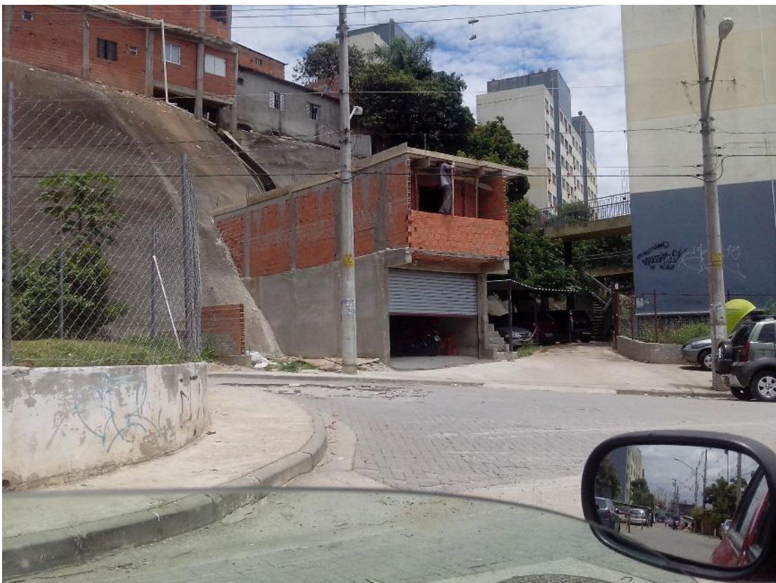
Figura 14 Figura 15 Ocupação sobre drenagem de obra de estabilização.. Foto: Zuquim, 2015
