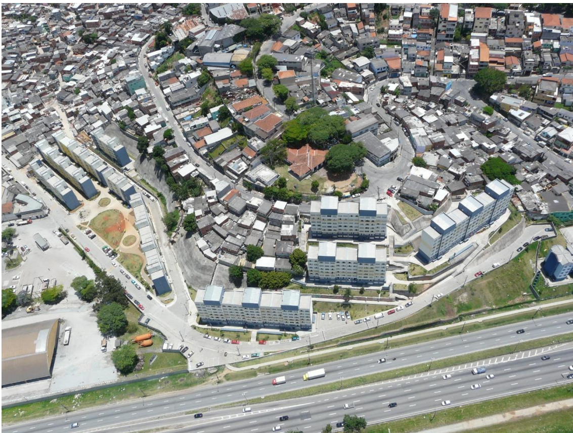
Figura 1 Depois da Intervenção. Foto: NAPPLAC 2009.
