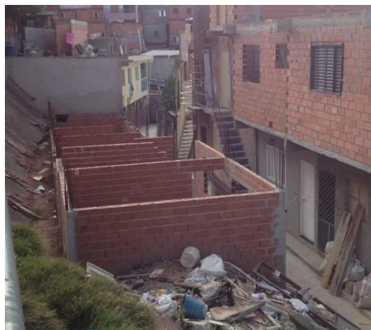
Figura 11 Ocupação de obras de estabilização - base talude Foto: Zuquim, 2015
