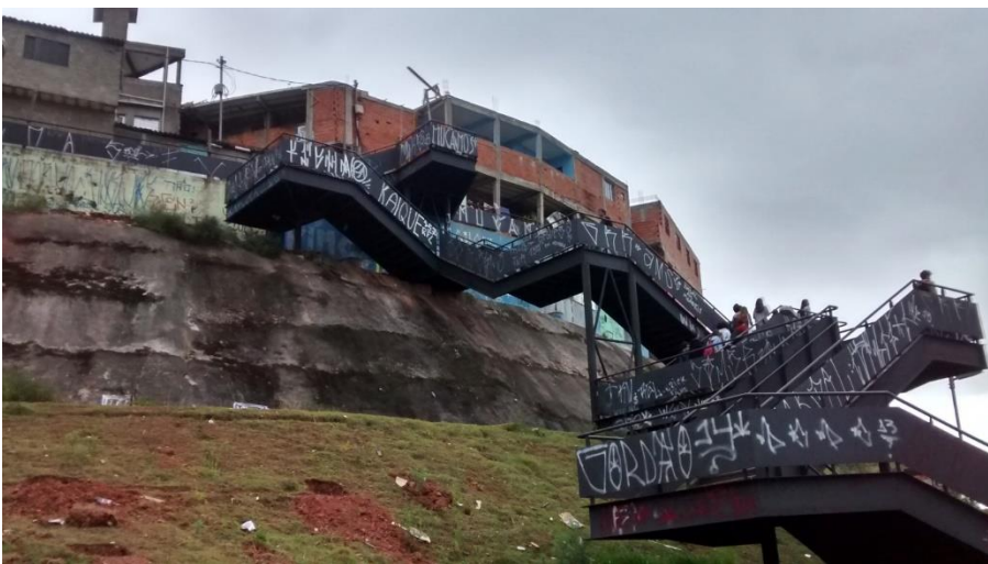
Figura 18 Início de ocupação de talude em área livre. Foto: Zuquim, 2015
