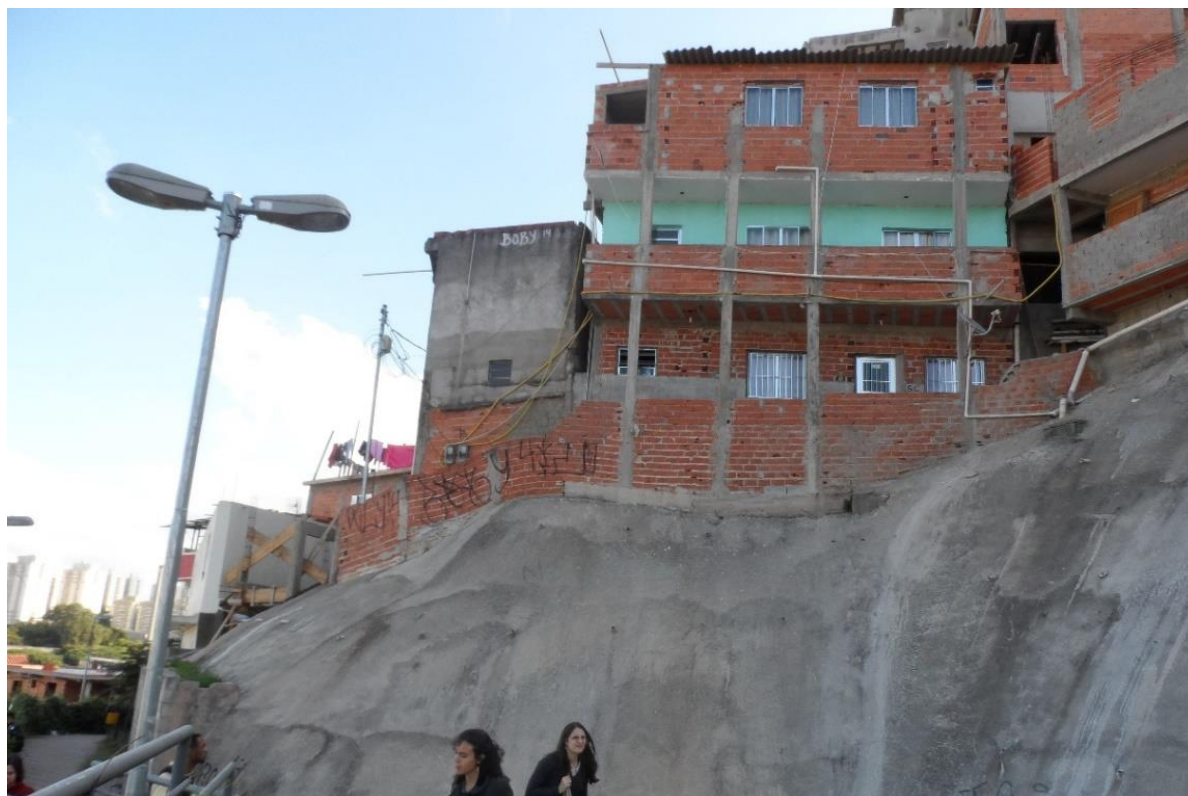
Figura 12 Verticalização sobre crista do talude Foto: Zuquim, 2015
