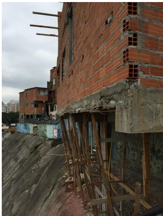
Figura 10 Ocupação de obras de estabilização - crista talude Foto: Zuquim, 2015
