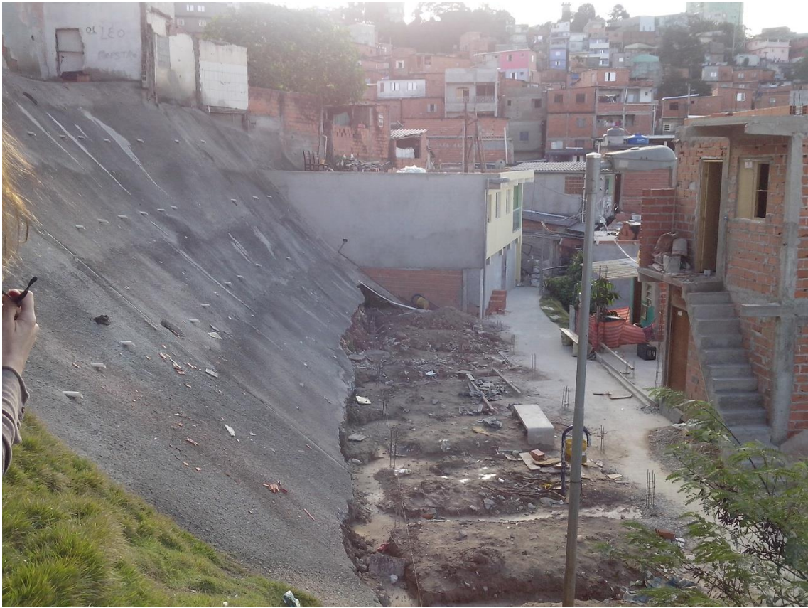
Figura 9 Ocupação de obras de estabilização - base talude. Foto: Zuquim, 2015
