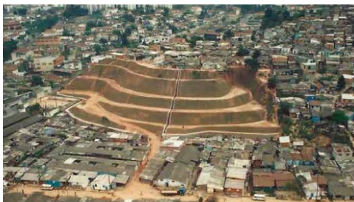
Figura 15 – Retaludamento da encosta com risco de deslizamento
