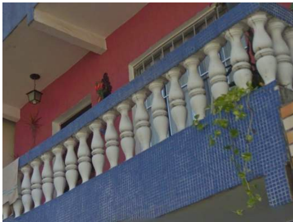
Figuras 65, 66 e 67 – Eixos consolidados: guarda-corpos em balaústres de concreto (esq.) e inox (dir.) e tintas de cores vivas (abaixo)
