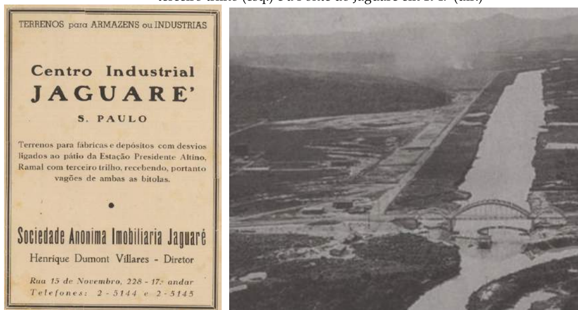
Figuras 5 e 6 – Anúncio de terrenos para armazéns ou indústrias publicado em 1946 enfatizando o terceiro trilho (esq.) e a Ponte do Jaguaré em 1947 (dir.)
