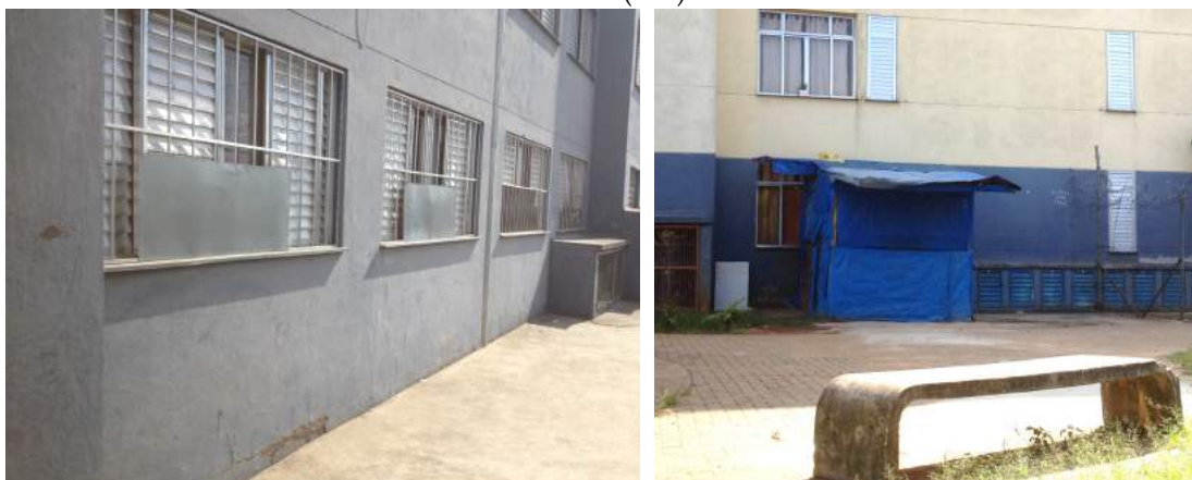
Figuras 63 e 64– Conjunto Nova Jaguaré: placas de aço em janelas (esq.) e ponto de comércio como extensão da casa (dir.) – maio de 2015.
