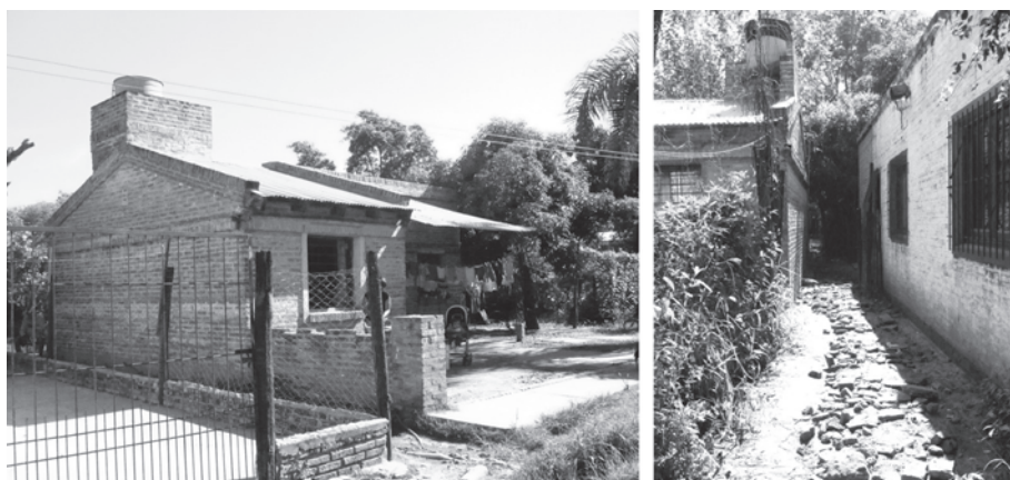
Figura 10 – Viviendas aisladas construidas en el asentamiento
